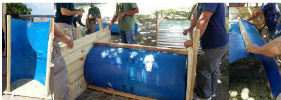
Colocar las maderas que formarán el frente y fondo del refugio. Estas deben superar la altura de los listones para facilitar la colocación posterior del material aislante.
