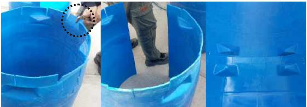
Realizar cortes a diferentes distancias en el extremo más angosto del tambor. Utilizar una pinza pico de loro para abrir y ensanchar ese extremo para facilitar su unión con el otro tambor. Es recomendable realizar esta tarea en épocas de mayor temperatura para manejar fácilmente el material.
