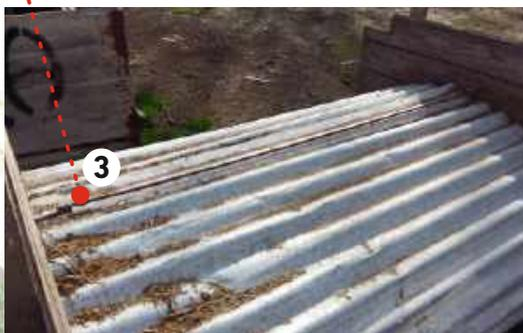
Instalar dos varillas a lo largo del interior del refugio. La tercera se coloca en el exterior y a lo largo de la chapa superior.
