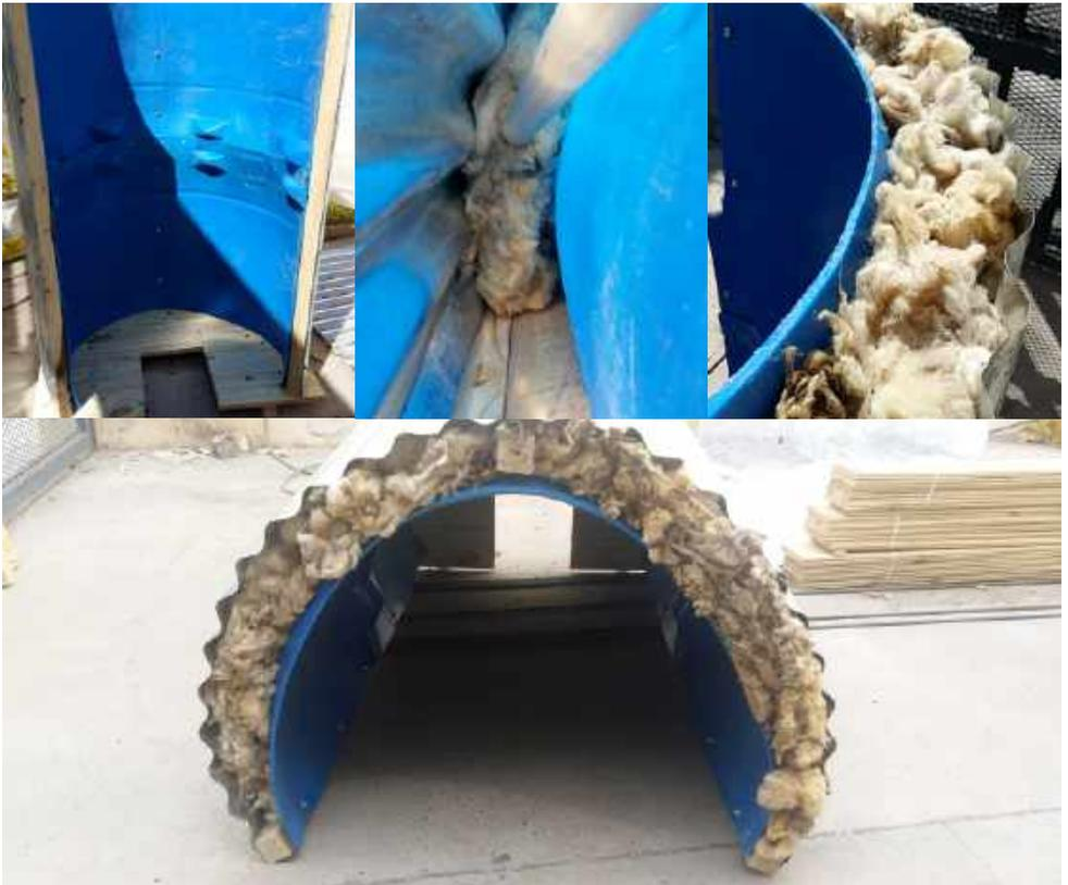
Por último, se procede a la colocación de lana como material aislante. Para ello, es necesario extraer una de las tapas de madera para introducir la lana en el espacio que queda libre entre el techo del tambor y la chapa. Es importante comprimir el material con ayuda de un palo para lograr que la lana quede apelmazada y eliminar todo el aire.
