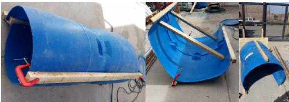
El tercer listón se coloca en el medio de la parte superior del tambor, en lo que será el techo del refugio. Fijarlo con prensa y ajustarlo con tornillos auto perforantes para techo. Los tres listones colocados servirán para unir las chapas y maderas con la estructura final del tambor.
