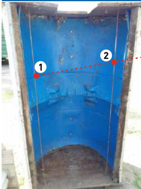
Luego del transcurso de un año de uso del refugio, se aconseja colocar varillas para tensarlo y evitar la apertura de las tapas. Se recomienda usar varillas de construcción que tengan roscas soldadas en sus extremos para colocar los tornillos.
